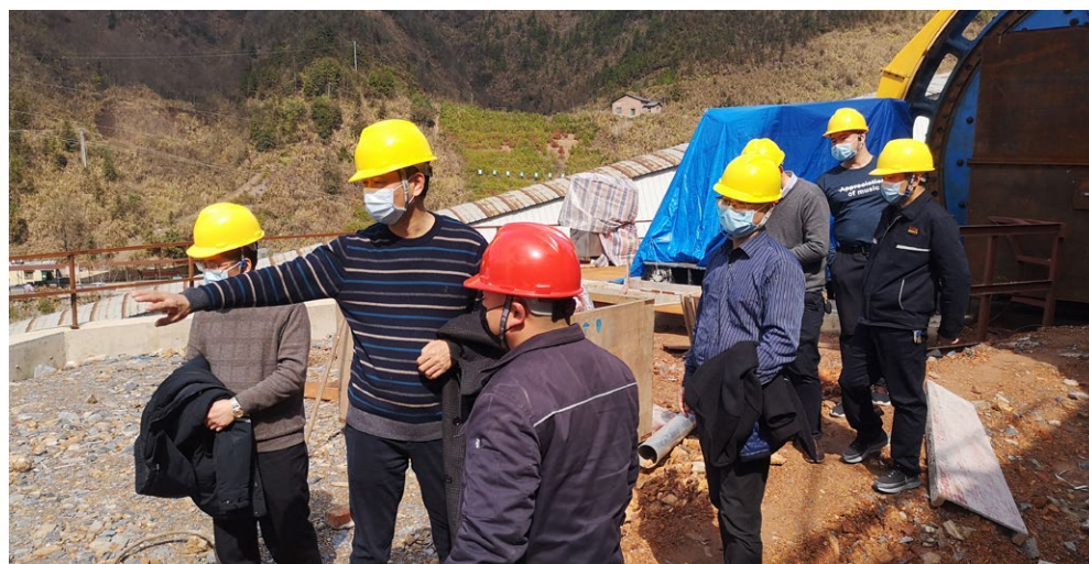
湖南黄金股份有限公司总经理陈建权到湖南黄金洞矿业检查施工进度
