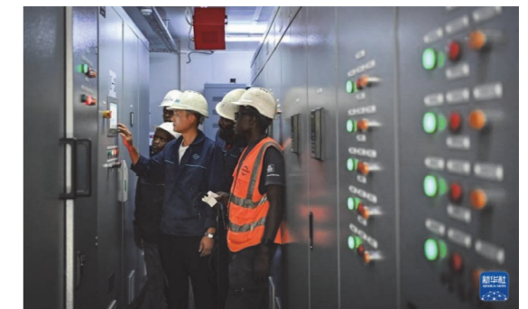
在索西安地热电站，中方技术人员指导当地工友进行设备操控
