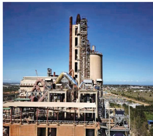
华新水泥坦桑尼亚水泥厂现场
