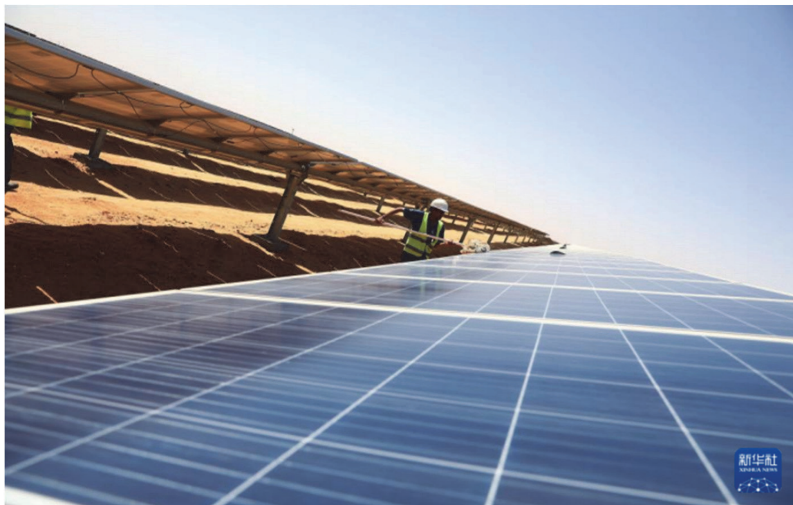
本班光伏产业园，工人对光伏组件进行尘土清除工作
