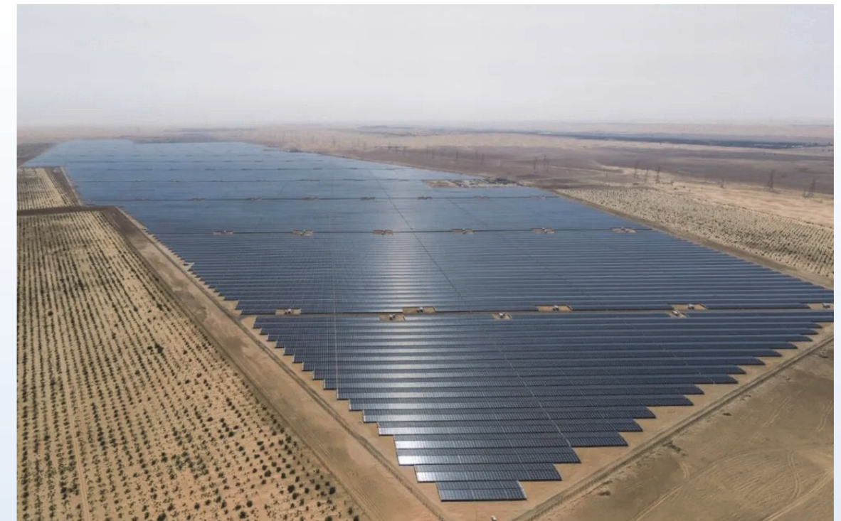
阿尔及利亚迈盖耶尔省光伏电站
