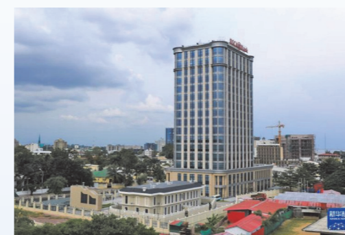
位于刚果（布）首都布拉柴维尔的中刚非洲银行办公大楼
