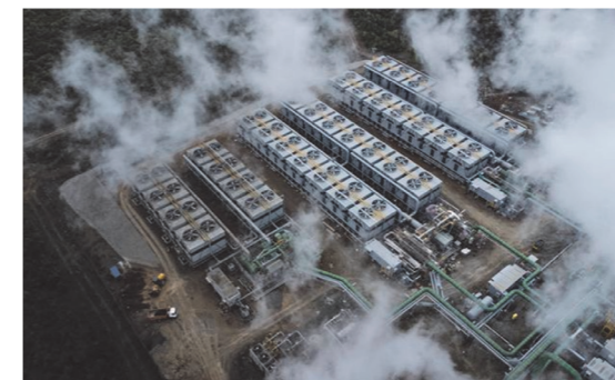
肯尼亚纳库鲁市的索西安地热电站项目建设现场
