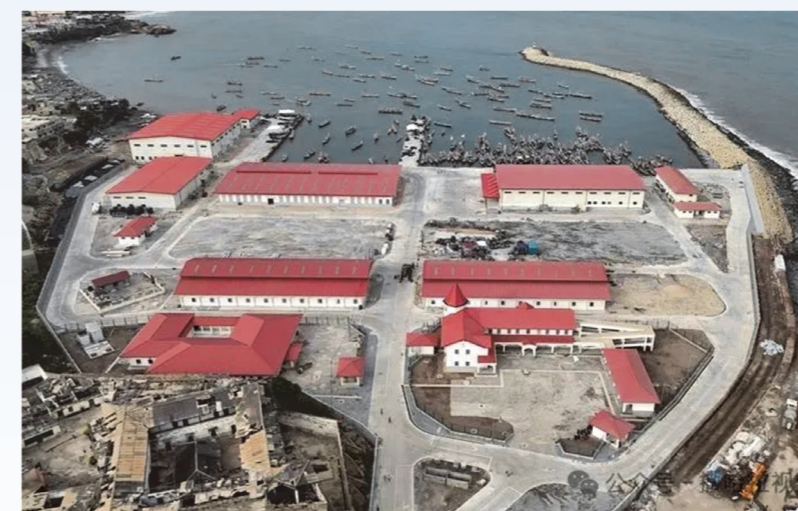
中国援建的加纳渔港综合设施项目
